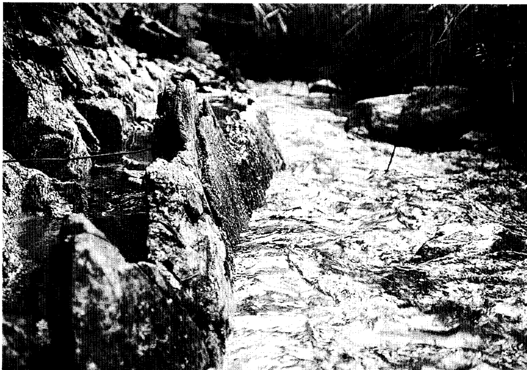
図8 [K-4A] を上流から下流へ見る 左岸花崗岩との間は侵食を受けて溝になる
