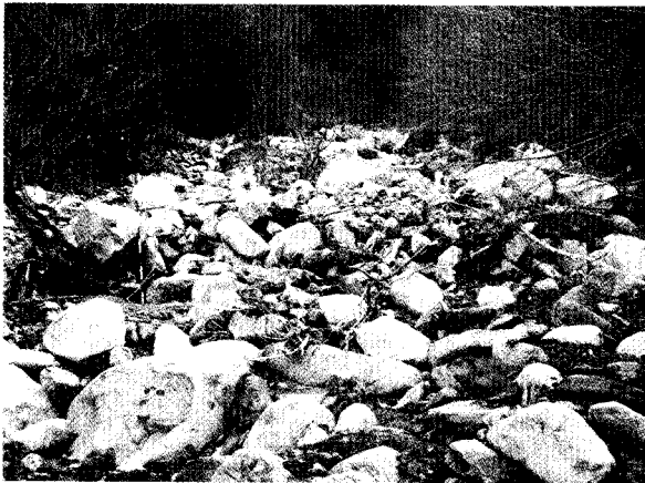
図17 本川の土石流堆 (No.16)
