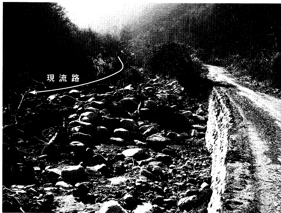
図16 本川の土石流堆フロント (No.13)
