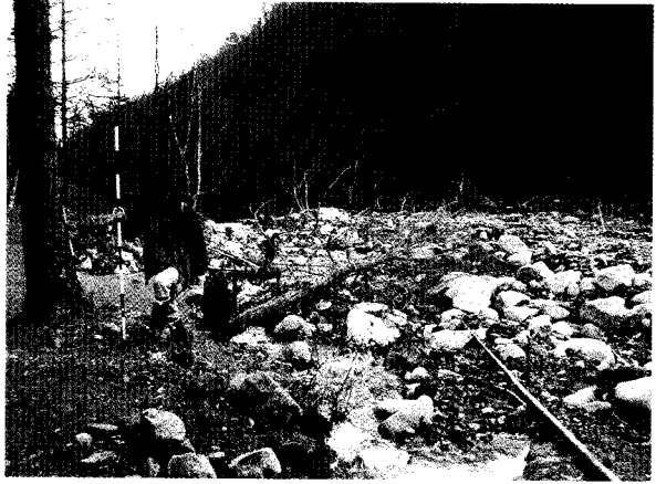
図12 発電所上砂防堰堤の上流側左岸(No.8)
