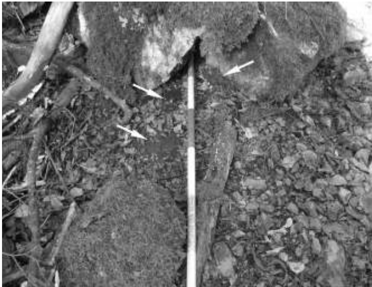
図8 岩塊斜面下端から流出した砂 矢印の先が示している黒い部分が流出した砂。
